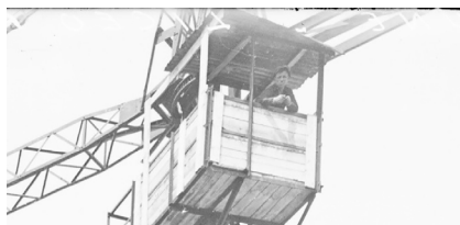
Figura 6. Dettaglio della figura 4: il gruista
