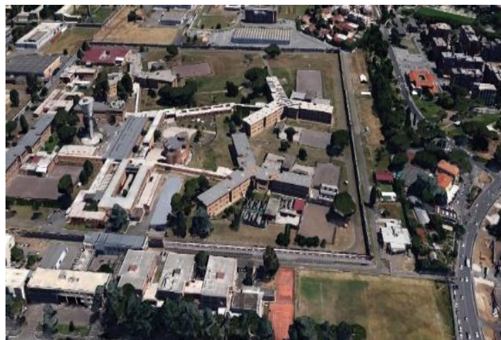
Fig. 2 – Foto attinta da © Italianacostruzioni.
