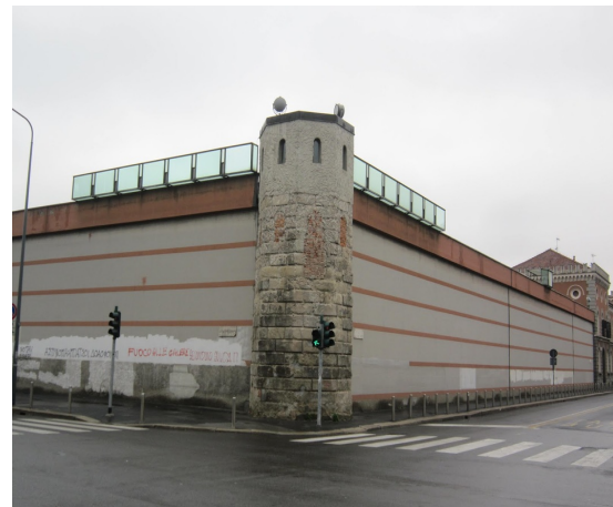
Fig. 4 – Muro del carcere di San Vittore a Milano (2007).
