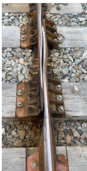
Fig. 4 – Ballast, traverses, rail : joint de dilatation (Biaris-Bretenoux). Photo de l'auteur.
