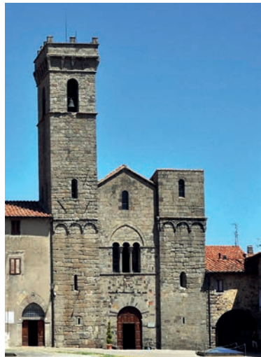
31. Abbazia di San Salvatore, Abbadia San Salvatore, facciata.
