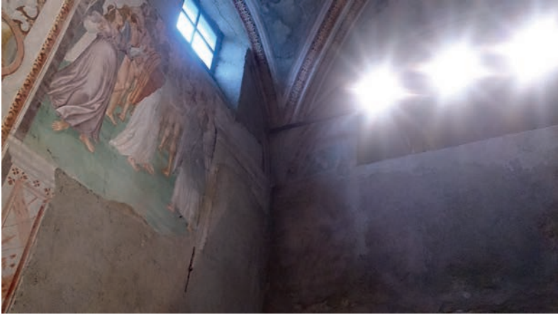
47. Chiesa dei Santi Nazaro e Celso, Scaria d'Intelvi, interno con traccia di apertura e di tribuna (poi modificata).
