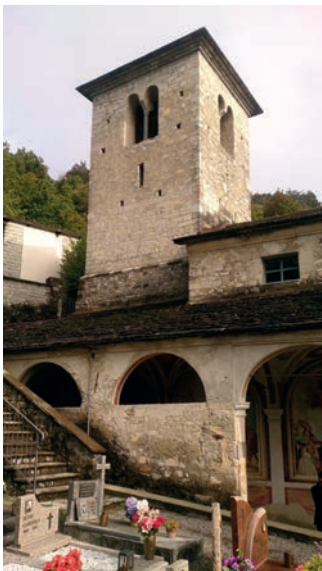
44. Chiesa dei Santi Nazaro e Celso, Scaria d'Intelvi, vista da sud-est.
