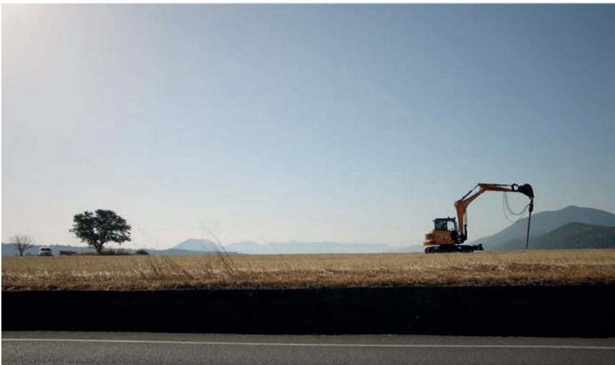
Figura 1. Lavori preliminari del lotto 1a Battipaglia-Romagnano Alta Velocità, foto di Simone Valitutto, 13/06/2024.
