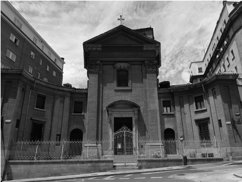
Fig. 9. Madrid, chiesa di San Carlo, esterno (foto C. Varagnoli, 2023).
