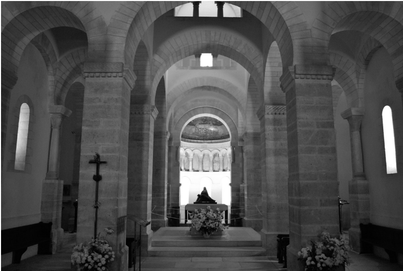
Fig. 4 Germigny-de-Prés, interior view.
